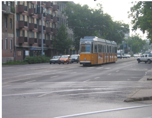
5. ábra Az átépítés után
