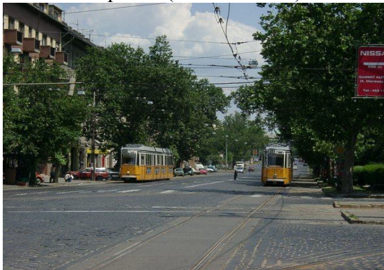
4. ábra Az átépítés előtt
